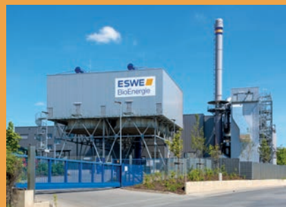
Biomasseheizkraftwerk der ESWE
